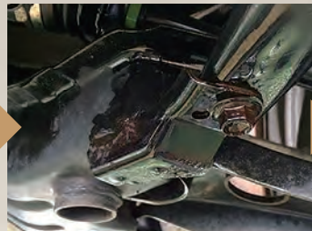
シフト錆転換剤 塗布
